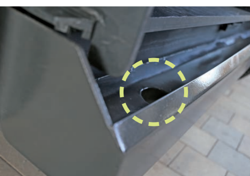
Sickersaftrinne mit Anschluss Ø 100 mm
